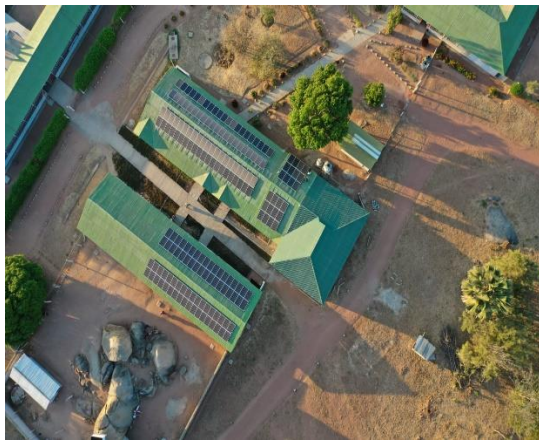
180 Sonnenkollektoren auf Pumas Dächern Foto:T.Oechler
