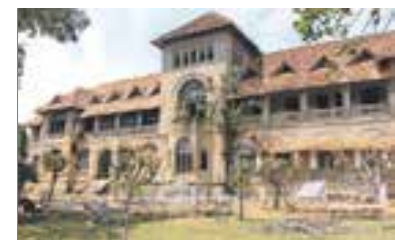
Spenden könnten helfen, das 1990 stillgelegte Krankenhaus in Tanga zu sanieren.
