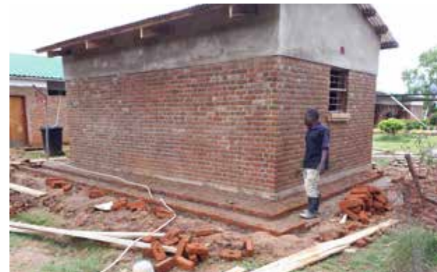
Technikhaus für das Hospital Kaseye in Malawi
