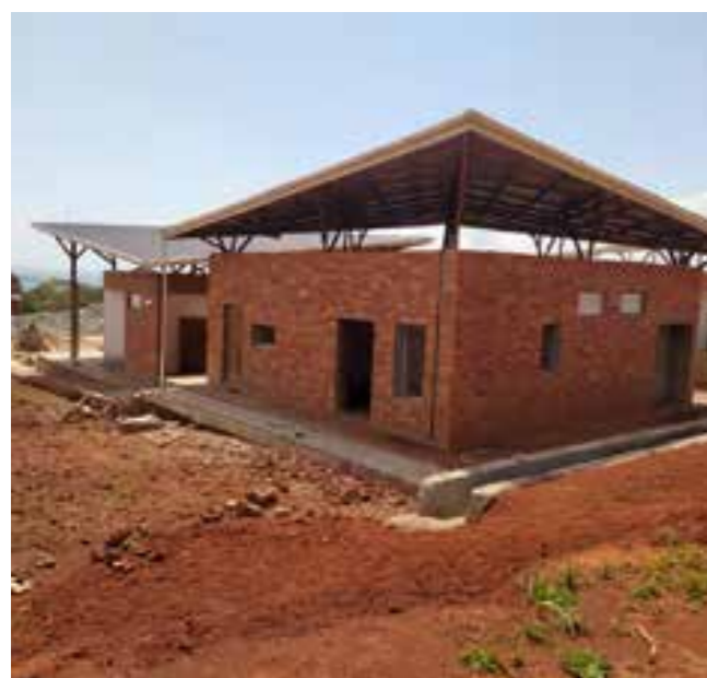
Im Hospitalneubau in Jinja - Uganda. werden später Interplast Teams operieren
