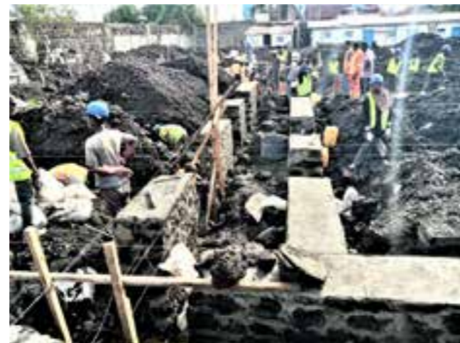
Die 1.20 m tiefen Grundmauern für 3 Stockwerke werden in der porösen Lava fixiert.
