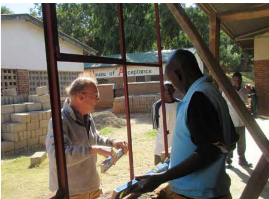
Thomas Hangartner überwacht den OP-Ausbau in Kaseye
